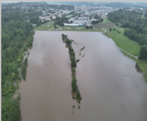
Hochwasserdamm im Wolfental, Biberach
